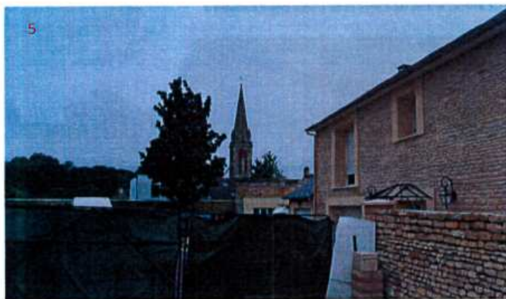
Vue proche depuis la rue d'Angleterre
