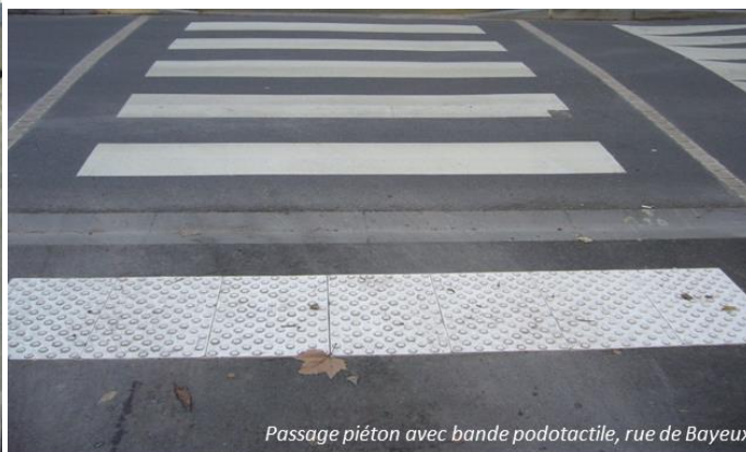
Cheminement piéton PMR, halte ferroviaire
