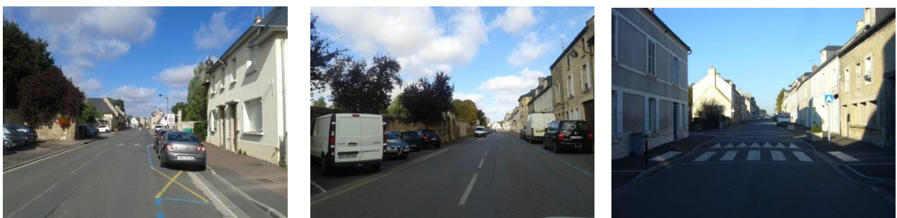
Profil urbain de la rue de Bayeux (bâti à l'alignement, stationnement, voirie linéaire)
