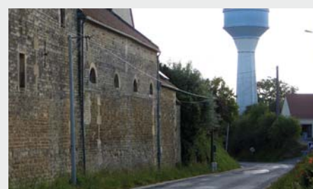
CHEMIN PIÉTONNIER RUE DU BOCAGE À CHEUX
