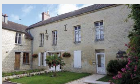
TRAVAUX MAIRIE ANNEXE DE BRETTEVILLE-L'ORGUEILLEUSE
